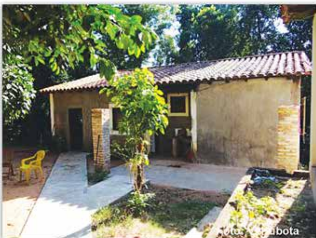
Foto 72. Vivienda de guardaparques
