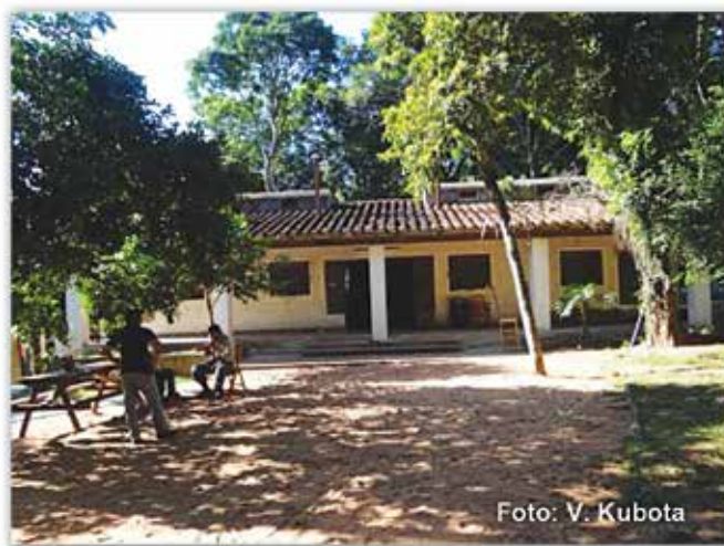
Foto 71. Vivienda de guardaparques (en reparación)
