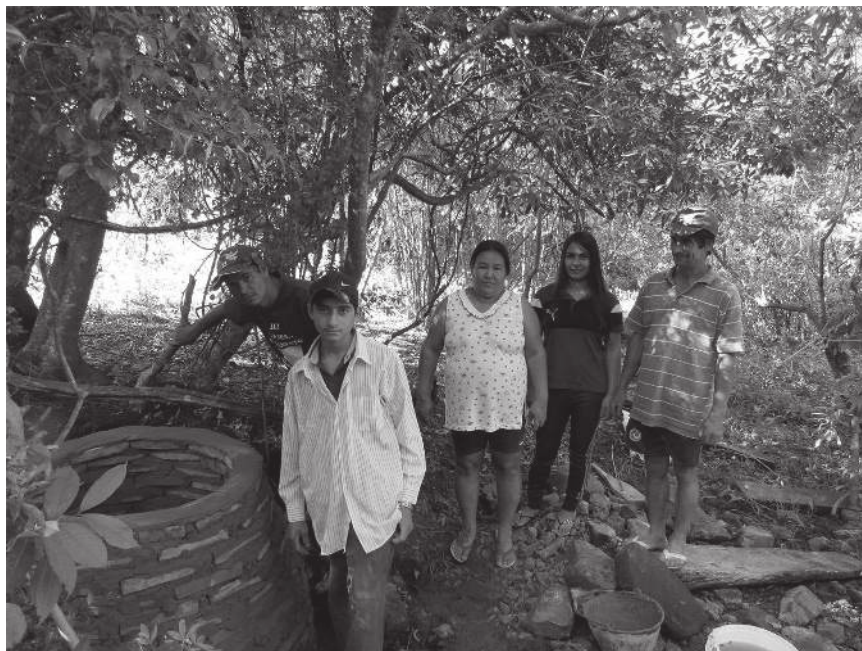
Construcción de protección de nacientes y manejo de agua. Jovere. 2018.
